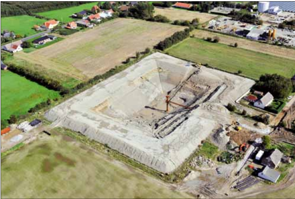
Bild 5. Baugrube des Erdbeckenwärmespeichers
