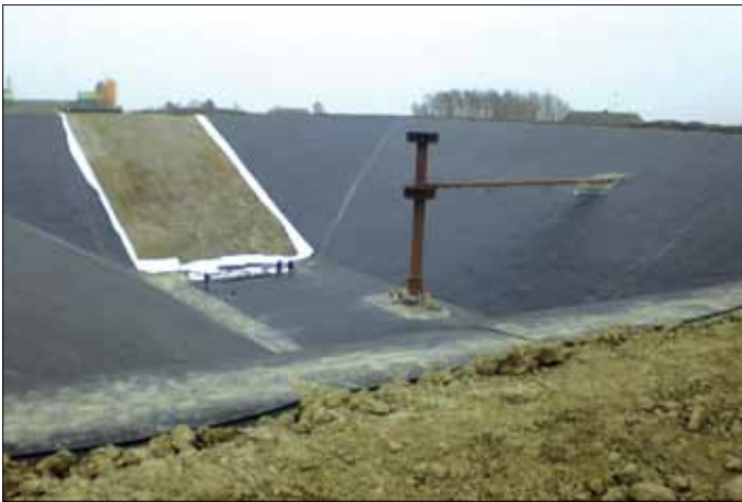
Bild 4. Fotos des Erdbeckenwärmespeichers während der Bauzeit: Auskleidung der Baugrube und Be-/Entladeturm (l.); Aufbringen der Abdeckfolie auf der Wasseroberfläche (r.)
