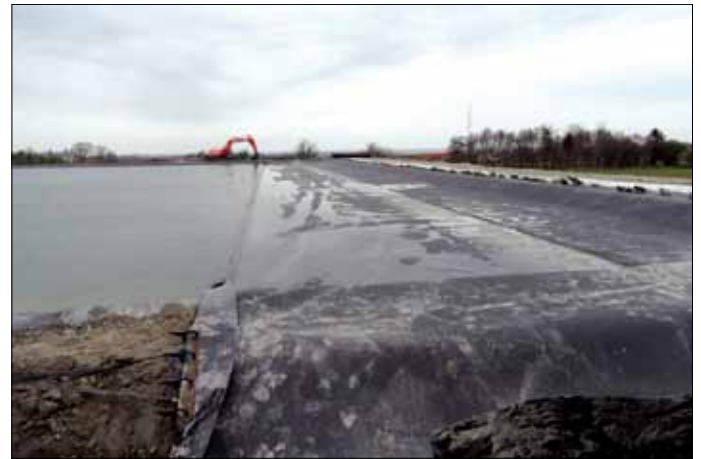
Bild 4. Fotos des Erdbeckenwärmespeichers während der Bauzeit: Auskleidung der Baugrube und Be-/Entladeturm (l.); Aufbringen der Abdeckfolie auf der Wasseroberfläche (r.)
