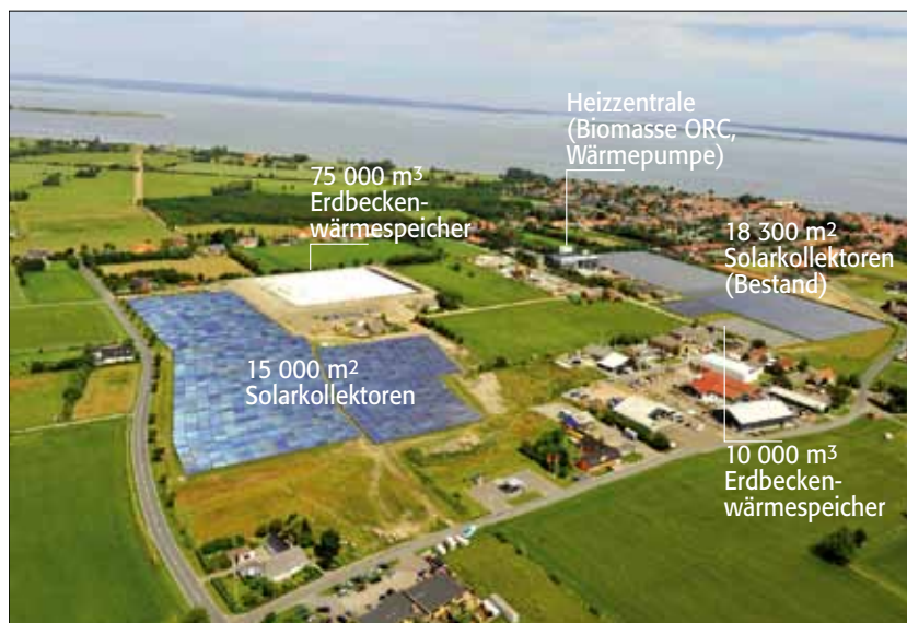
Bild 1. Ansicht der solaren Fernwärme in Marstal/Dänemark mit dem neuen Solarteil (l.) und der Bestandsanlage (r.)
