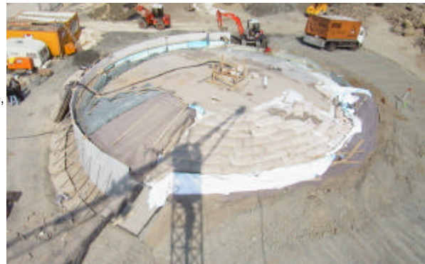
Bild 11: Wandaufbau und Speicher im Bau (Projekt Hannover-Kronsberg)
