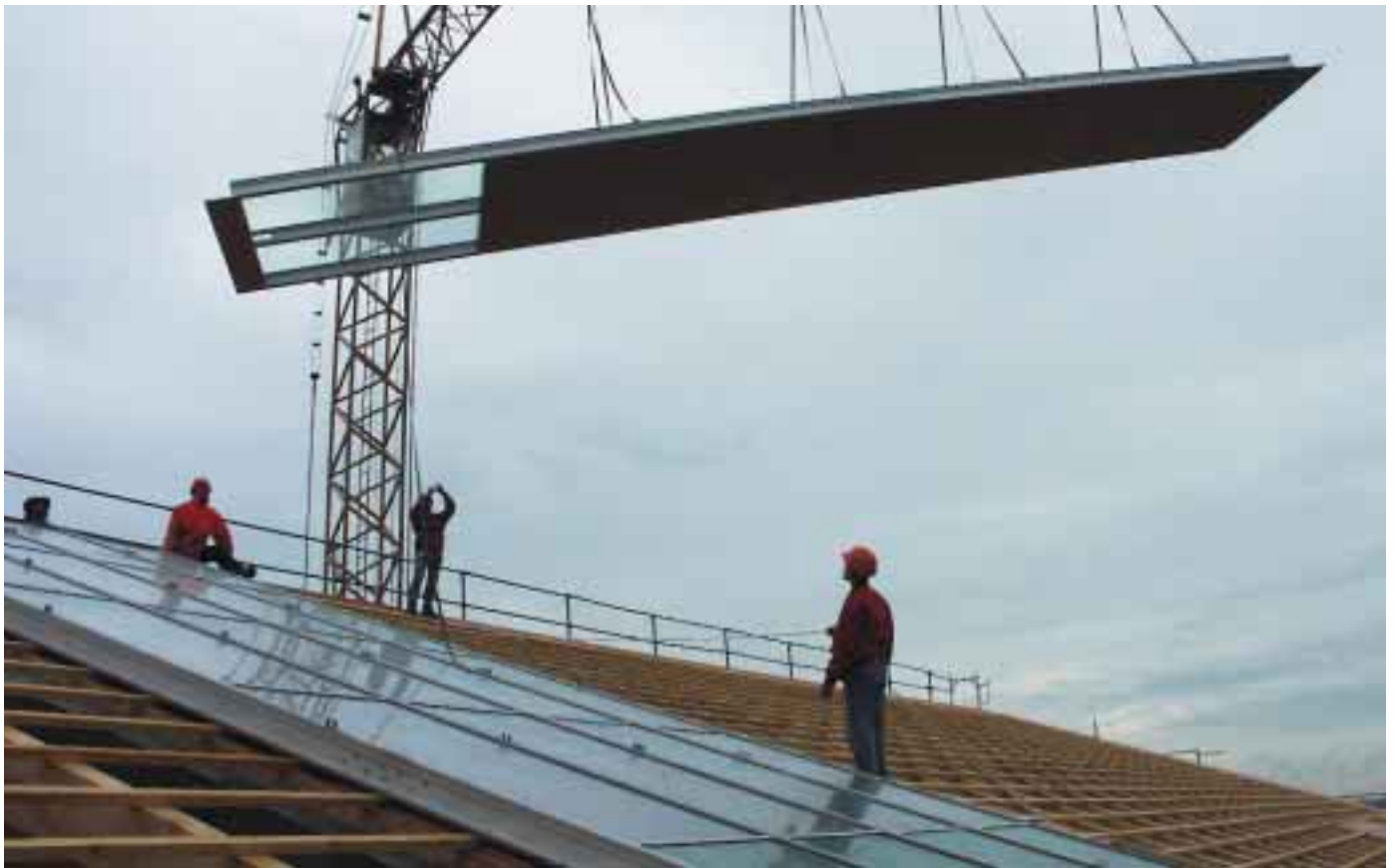
Montage von 535 m 2 Flachkollektorfläche mit integrierten Dachfenstern in Friedrichshafen im Juli 2004. Foto: ITW, Uni Stuttgart
