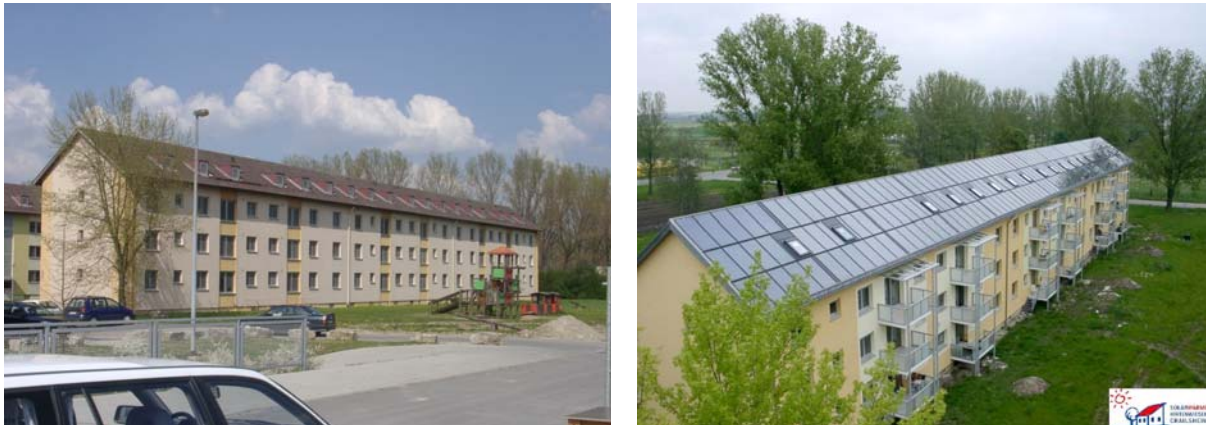
Bild 4: Kasernengebäude vor (links) und nach (rechts) der solaren Sanierung
