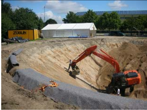
Ausheben der Speichergrube
