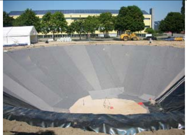
Schutzvlies und äußere, verschweißte Kunststoffbahn
