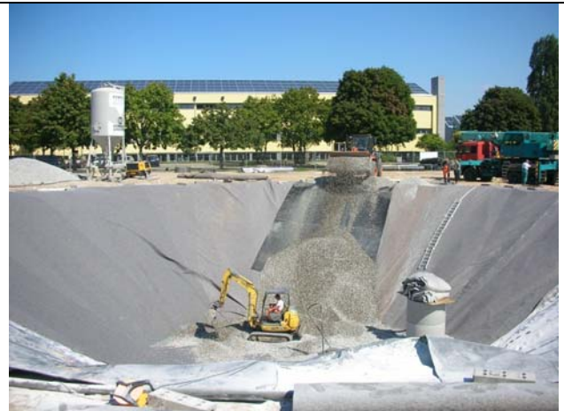
Innere Lage Schutzvlies, Einbau der unteren Kieslage
