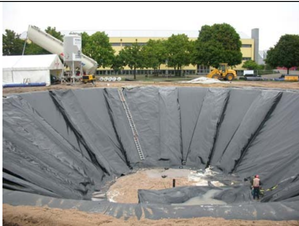
Innere Kunststoffbahn, erste Kammern mit Blähglasgranulat gefüllt
