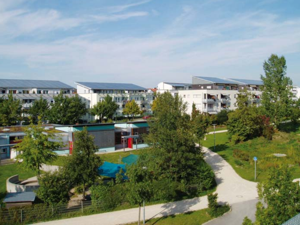
◀ Abbildung 1 SuN mit Erdbecken-Wärmespeicher in Neckarsulm
